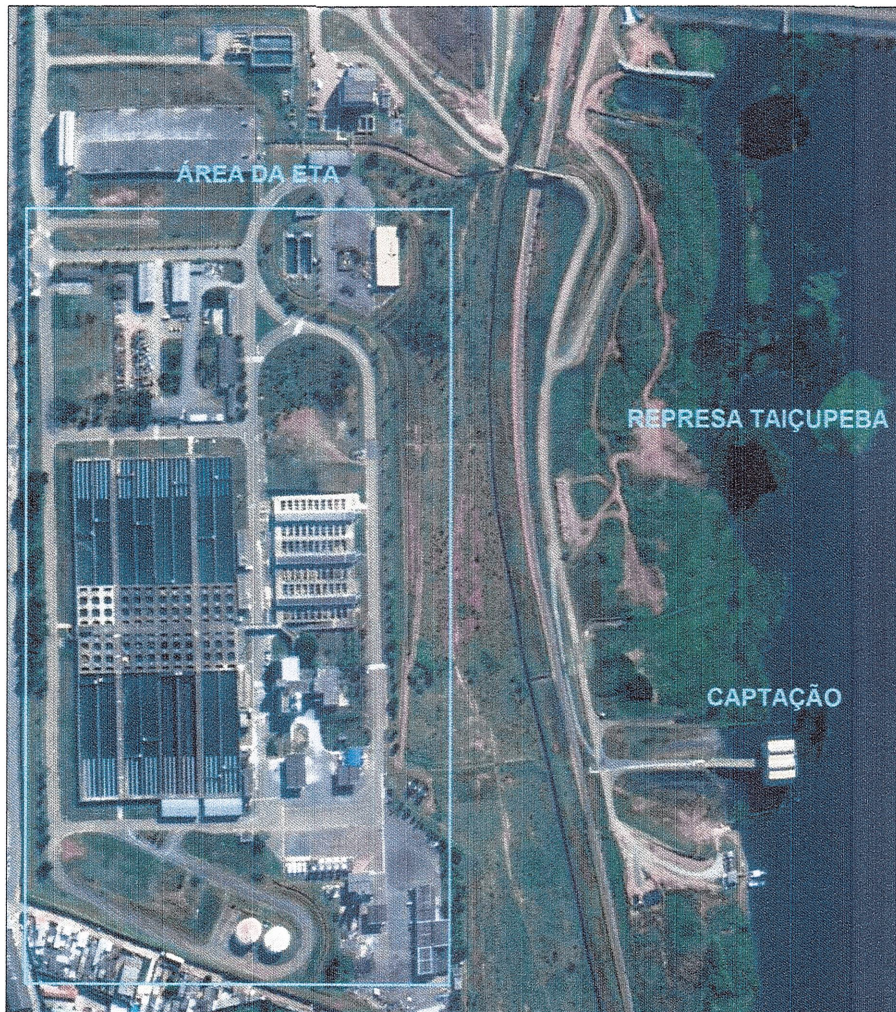
Figura 21 - Vista aérea da ETA Taiçupeba
