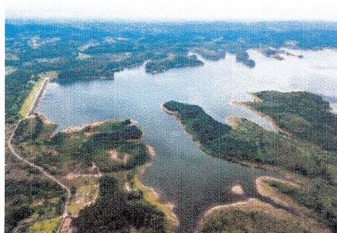
Figura 19 - Represa Ponte Nova Fonte: Sabesp
