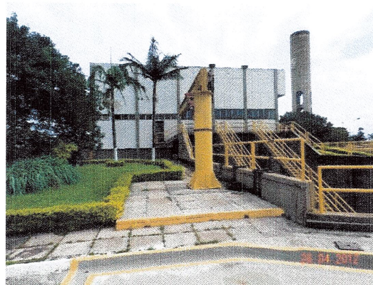
Figura 36 - Elevatória de Esgoto Final Fonte: Sabesp
