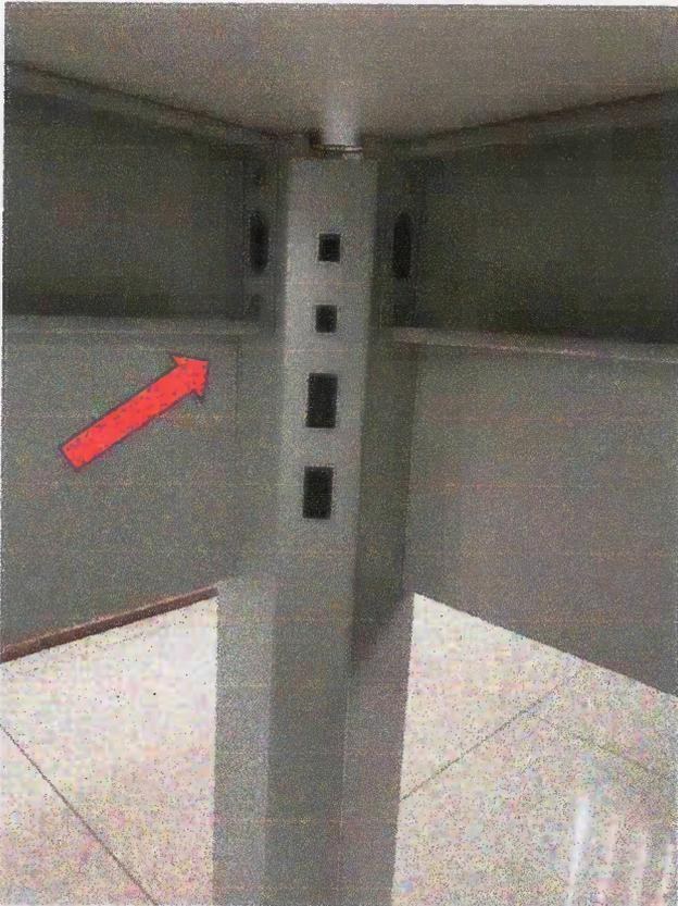
**EDITAL: A INTERLIGAÇÃO COM A CALHA DE PASSAGEM DE FIAÇÃO SE DA POR MEIO DE DUTO SEMICIRCULAR.**
