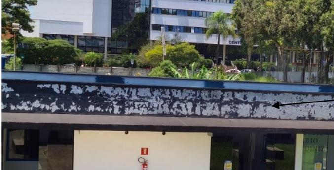
Falha no revestimento externo da parede e espelho d'água.
