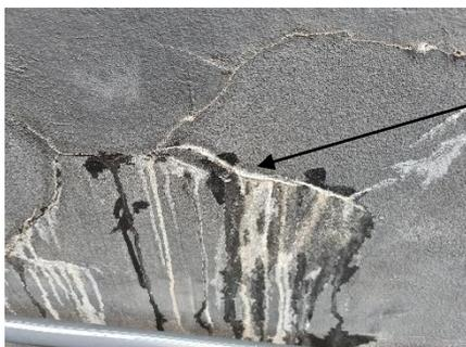
Fissuras nas paredes do espelho d'água.
