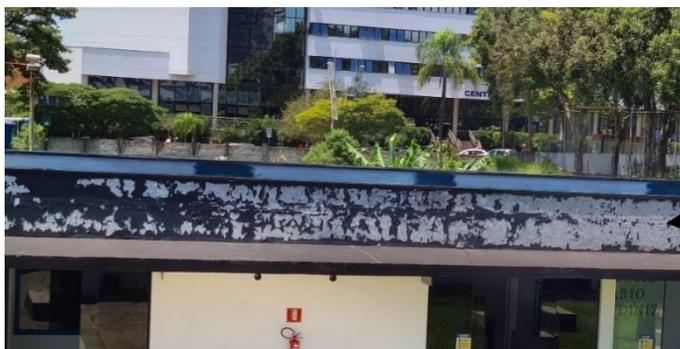
Falha no revestimento externo da parede o espelho d'água.
