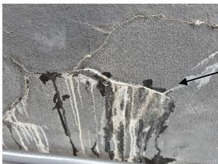
Fissuras nas paredes do espelho d'água.
